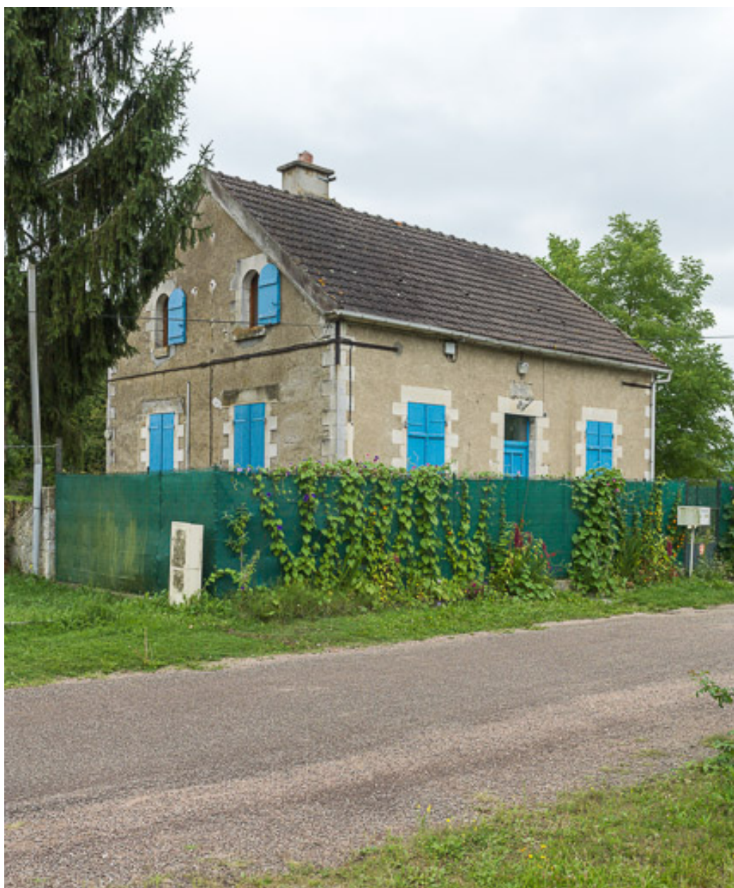
Vue de la maison éclusière.
