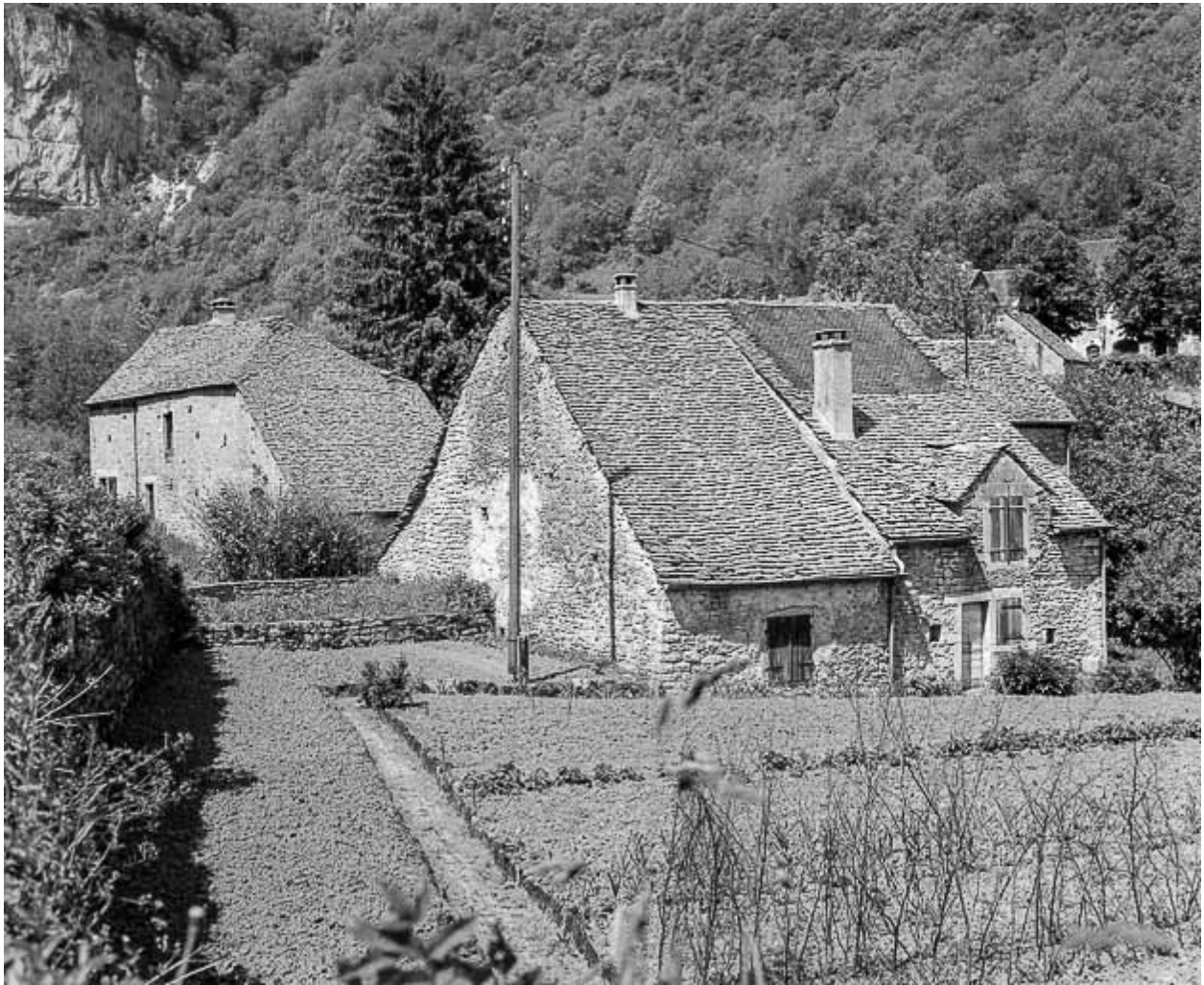
Ferme cadastrée AB 189 : vue de la façade antérieure et de la face droite.
