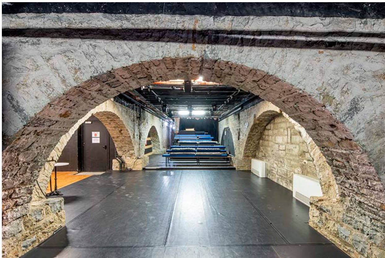
Sous-sol, salle secondaire.
