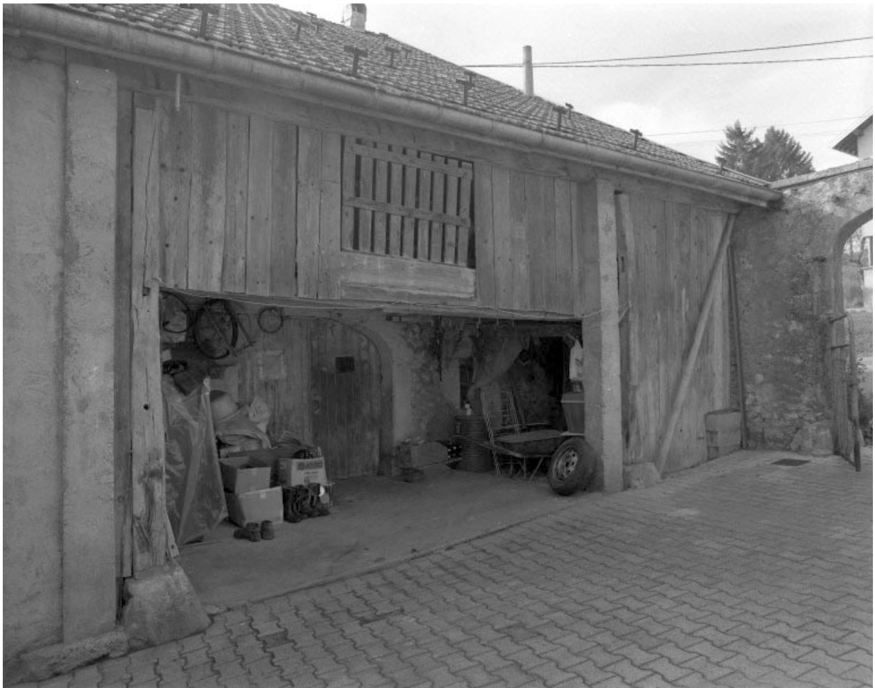
Accès à l'étable depuis la cour.
