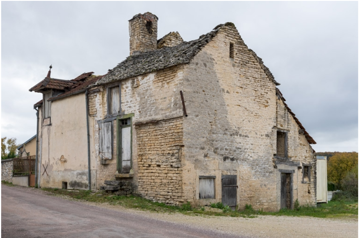
Vue d'ensemble depuis le sud.
