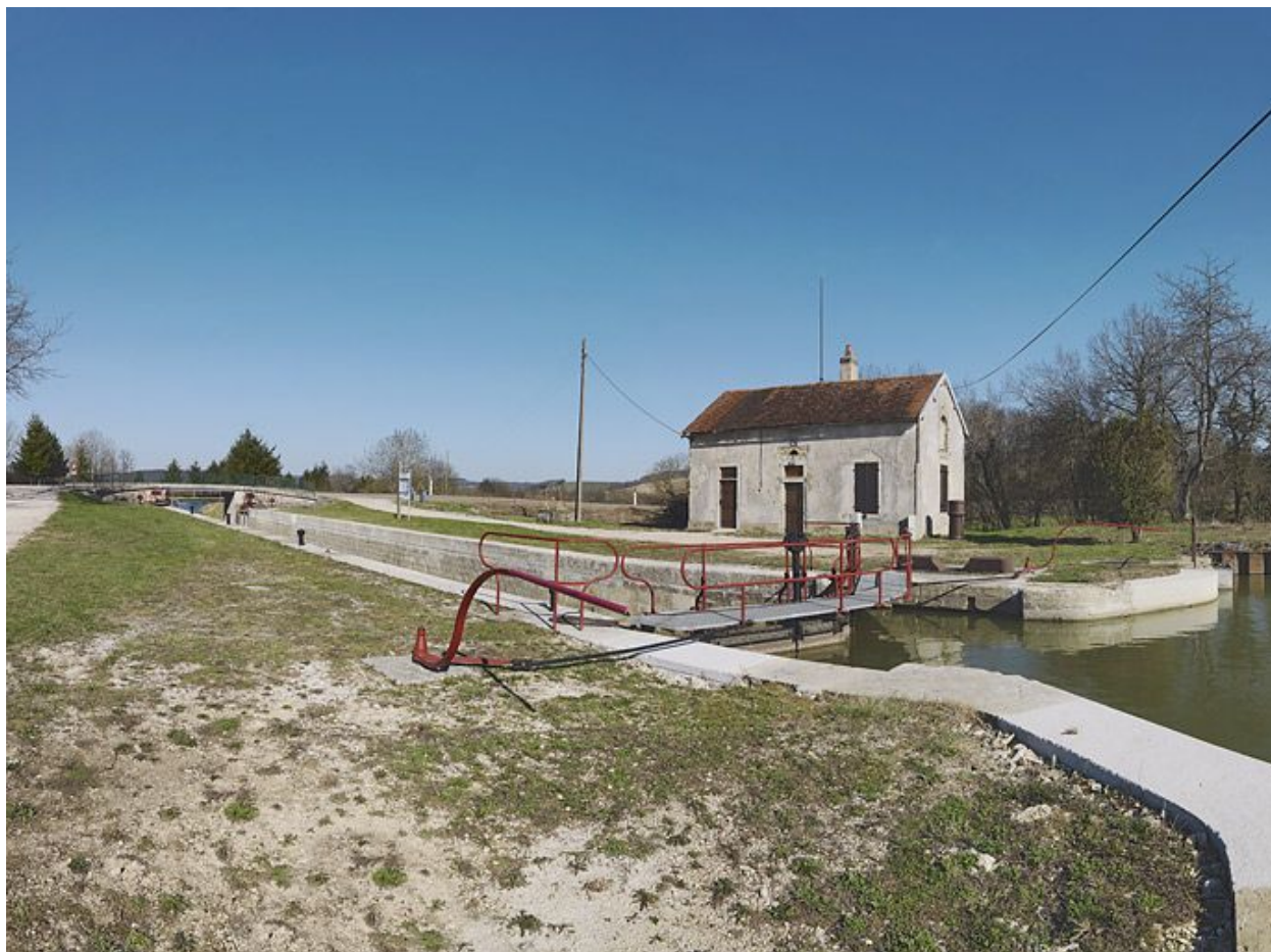
Le site d'écluse vu d'amont.
