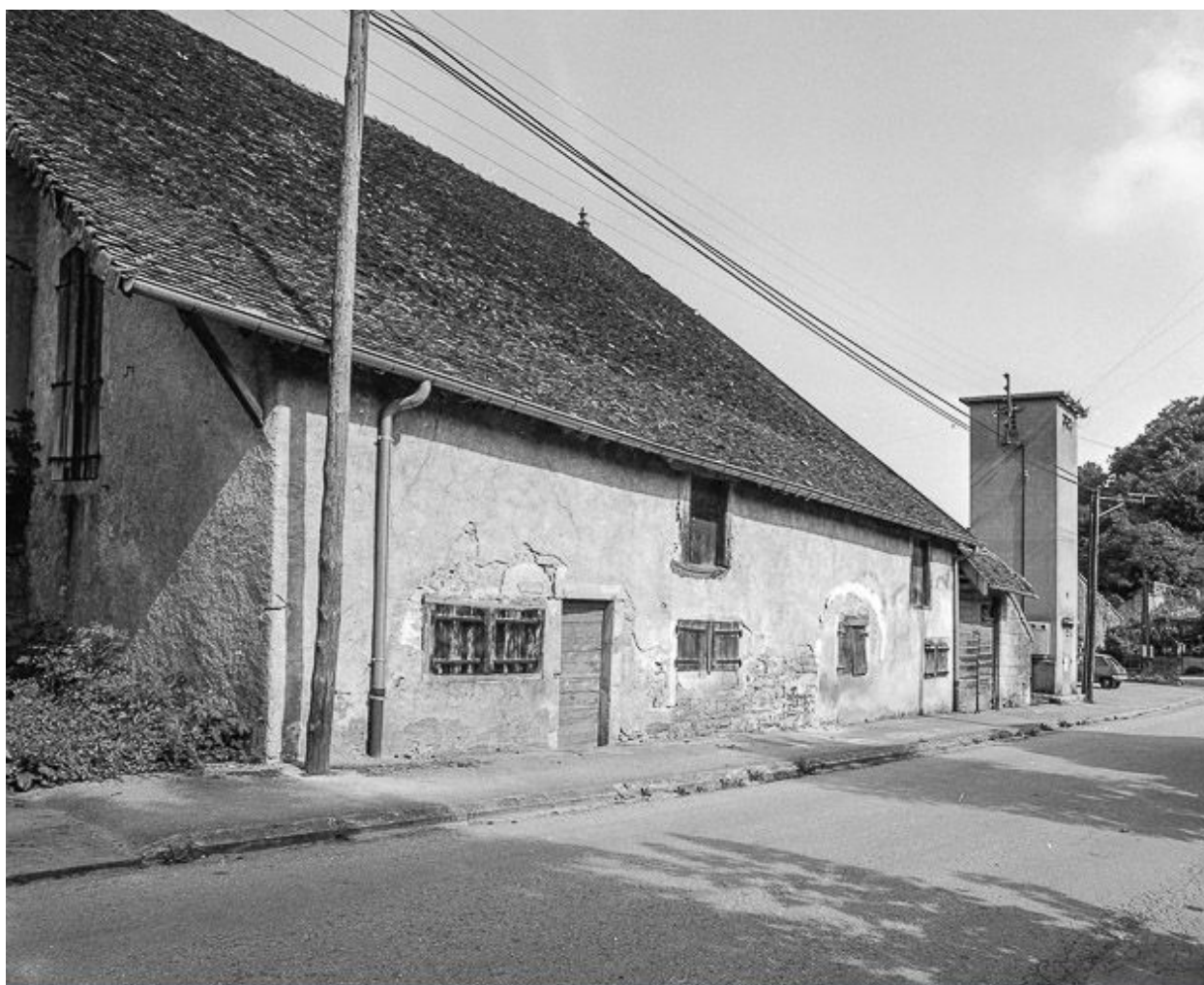
Façade sur rue, partie droite.
