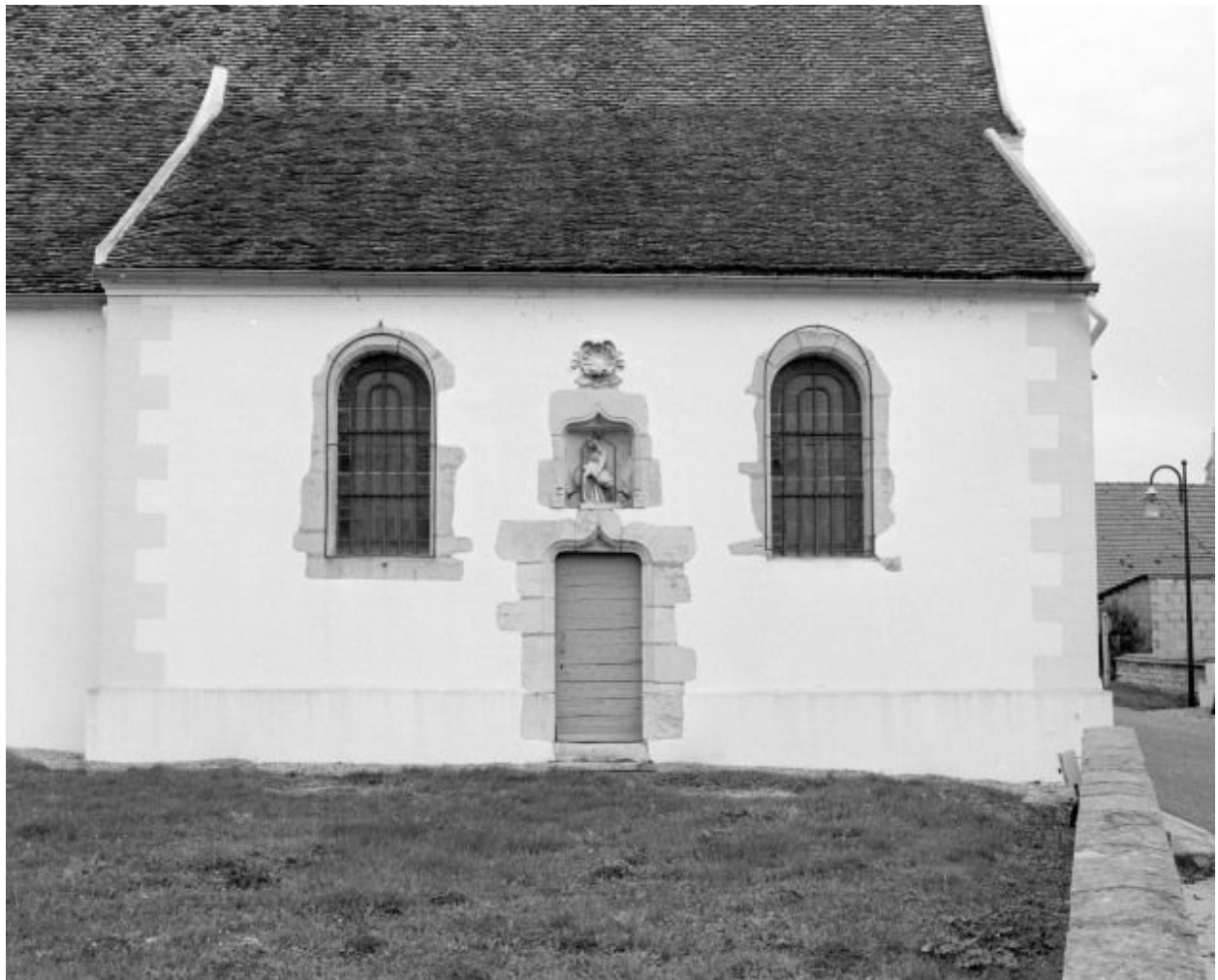
Elévation latérale de la chapelle gauche.
