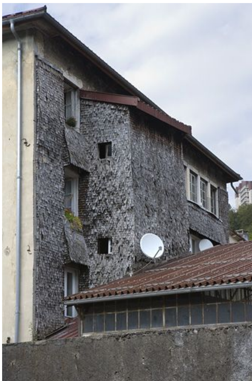
Façade latérale droite.
