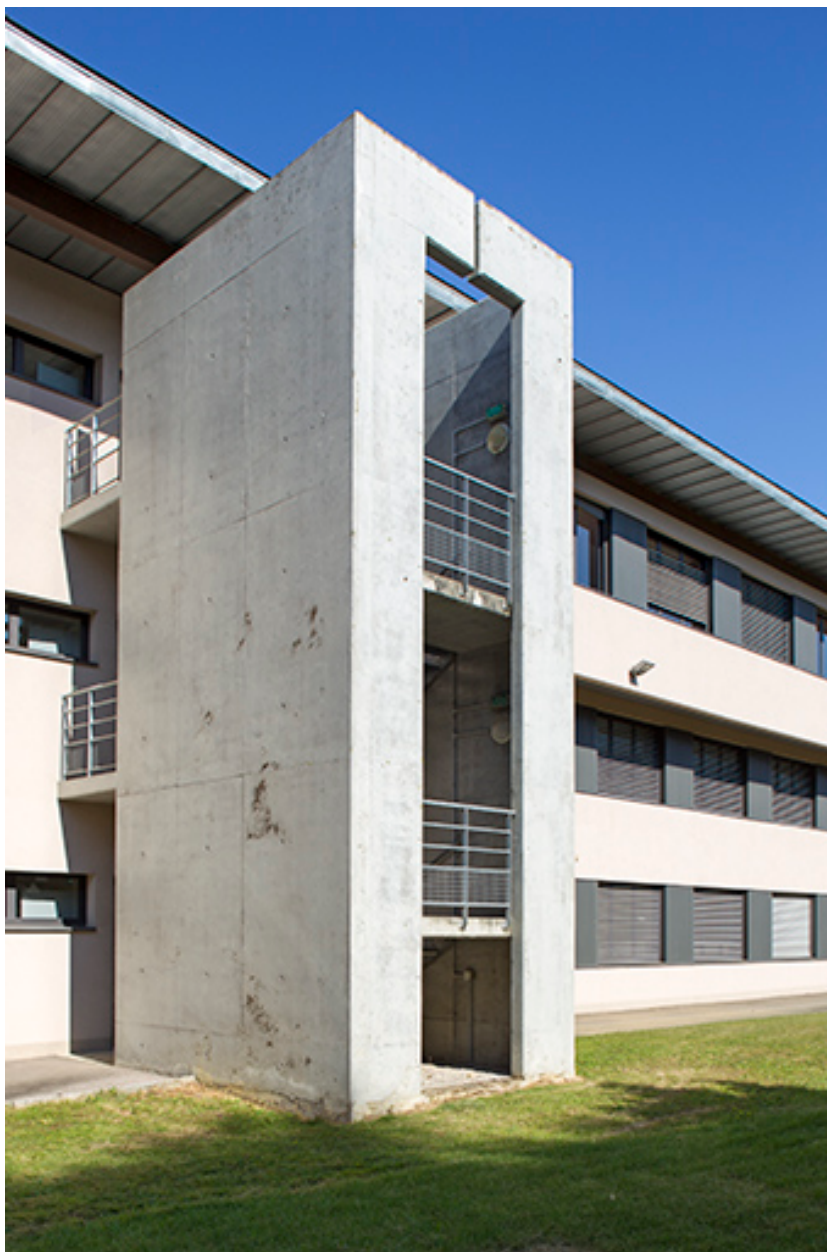
D tail de l'escalier de secours sur la fa ade post rieure de l'externat est, vu du sud-est.
