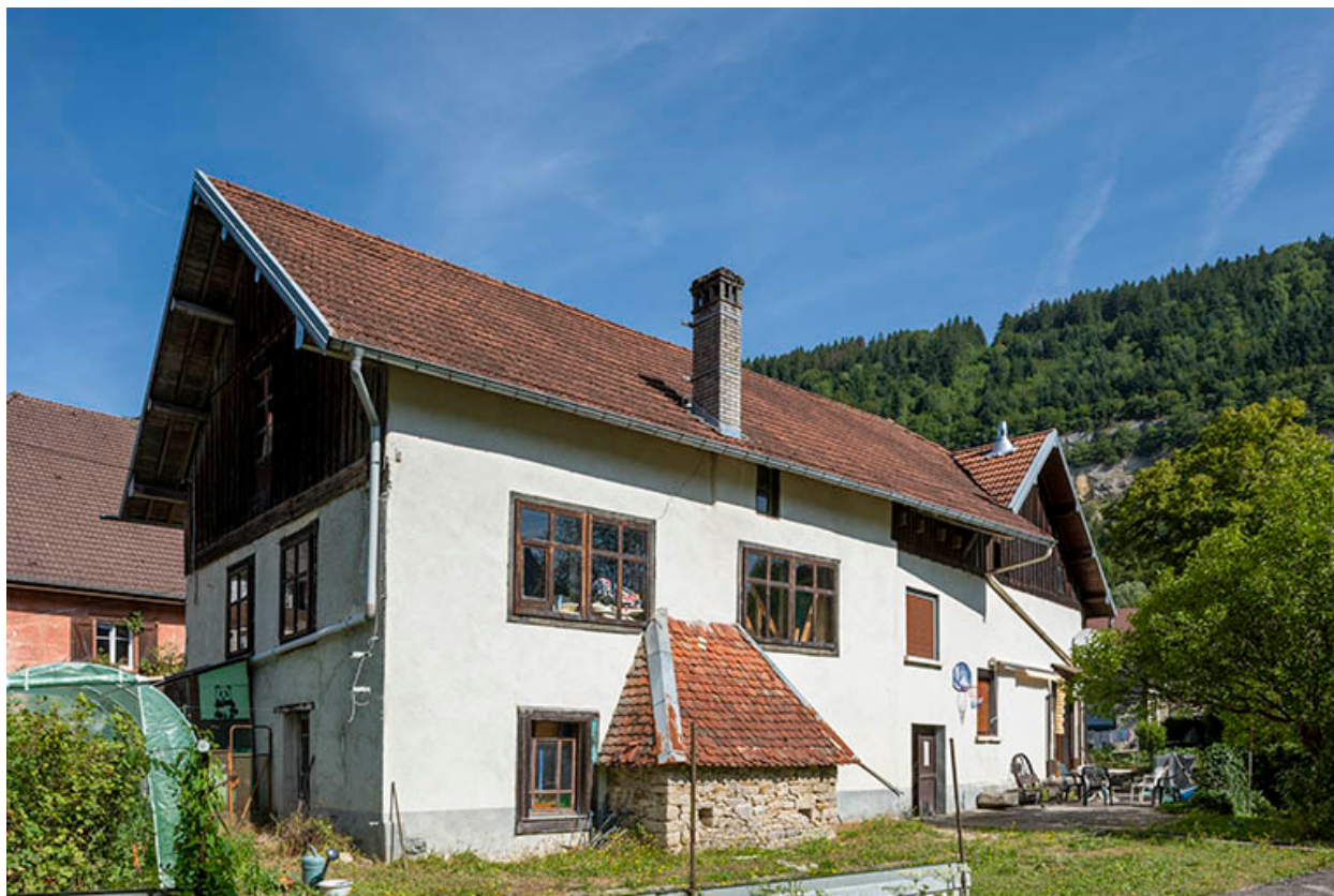
Forge : façades sud et est.
