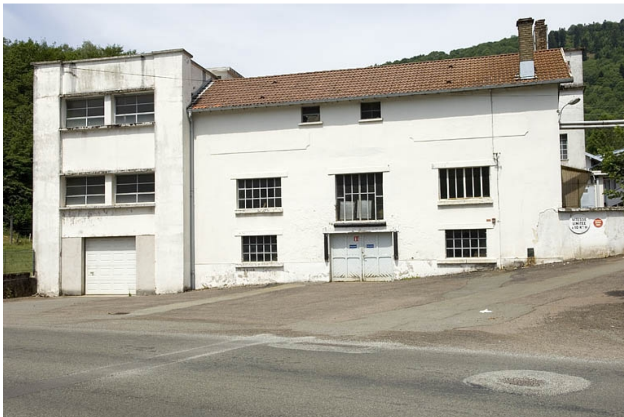
Façade sur la rue de France.
