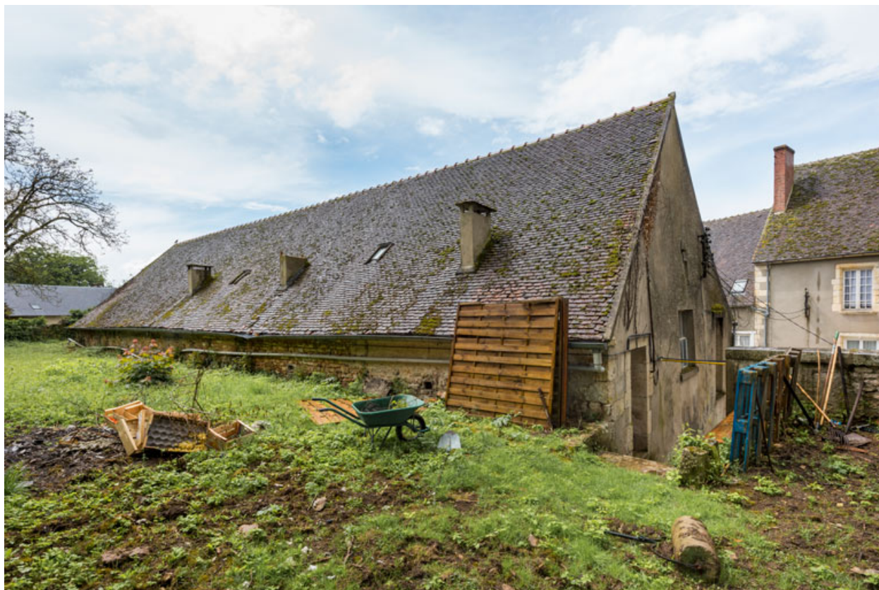
Façades postérieure et latérale gauche.
