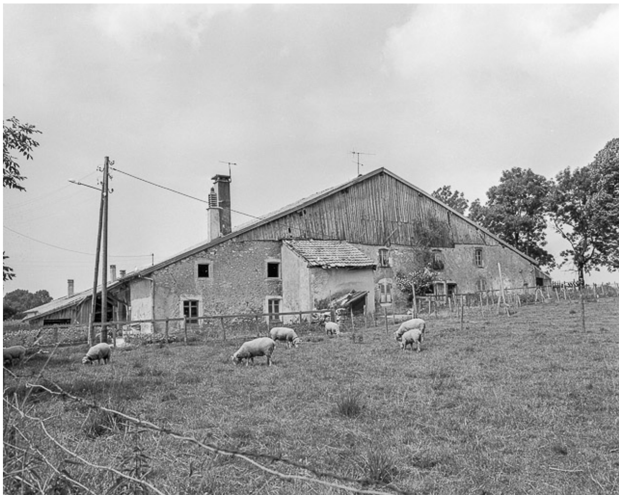
Pignon d'habitation et goutterot.
