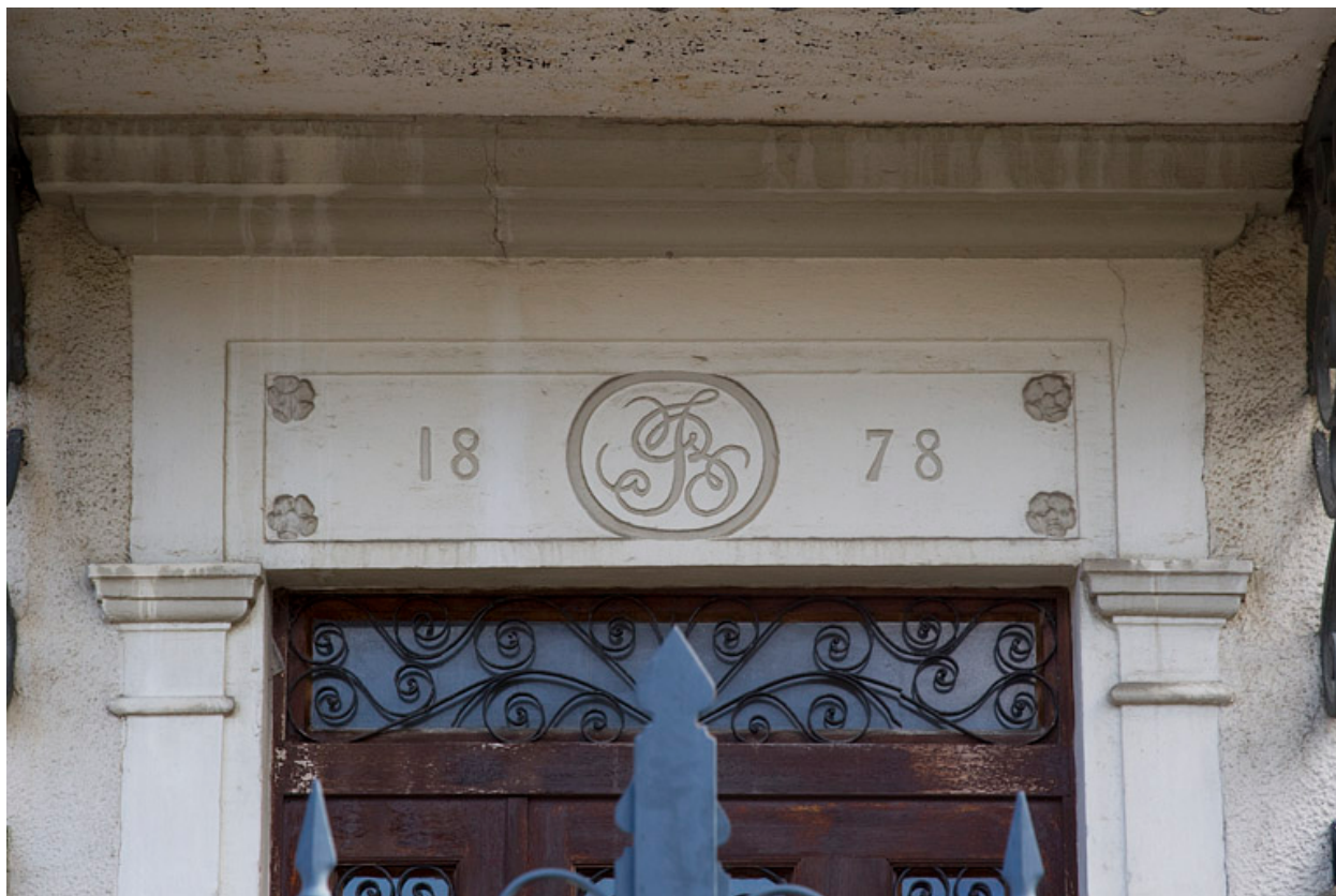
Logement patronal : linteau de la porte d'entrée.
