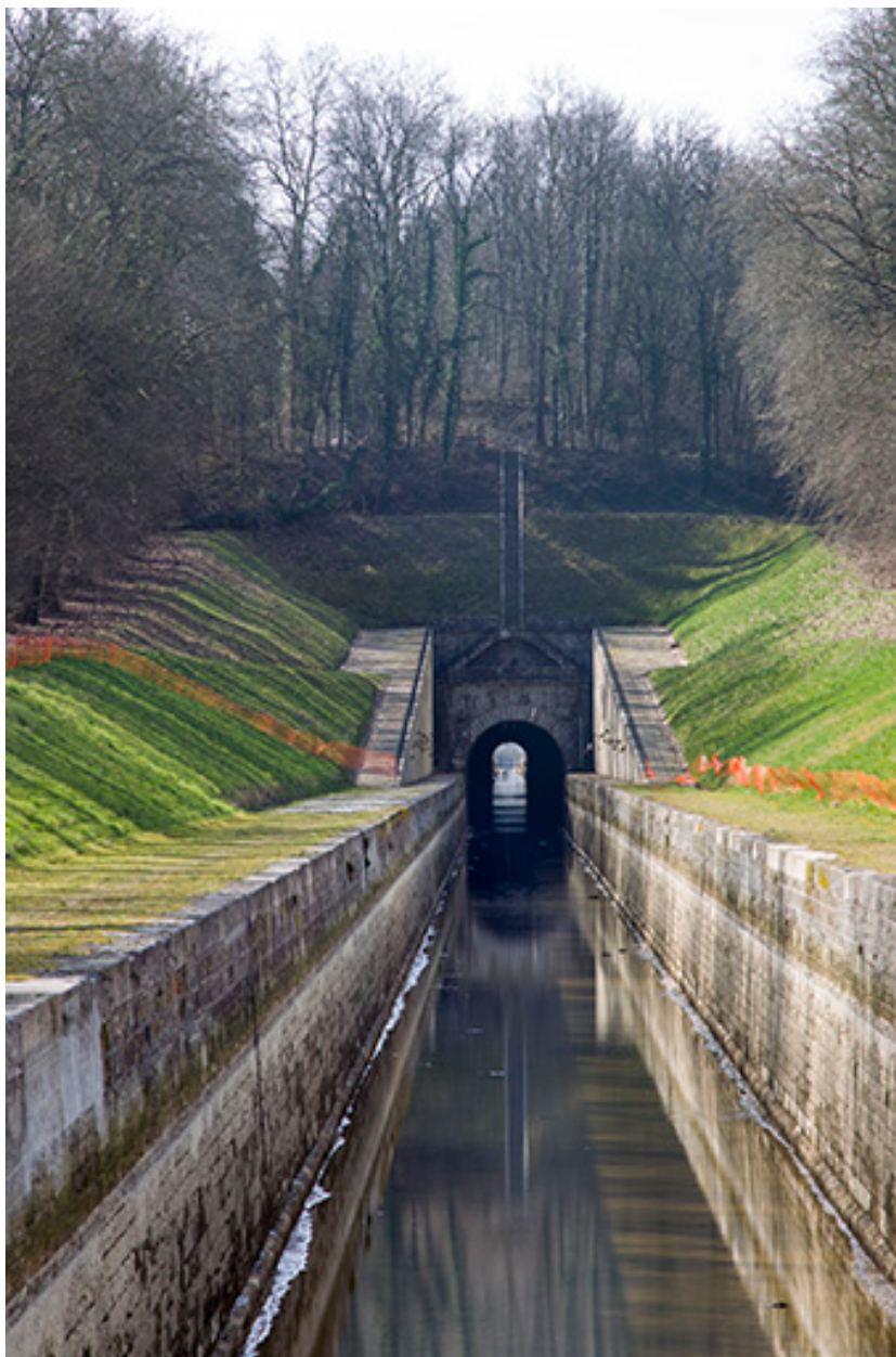
Le tunnel de Savoyeux.
