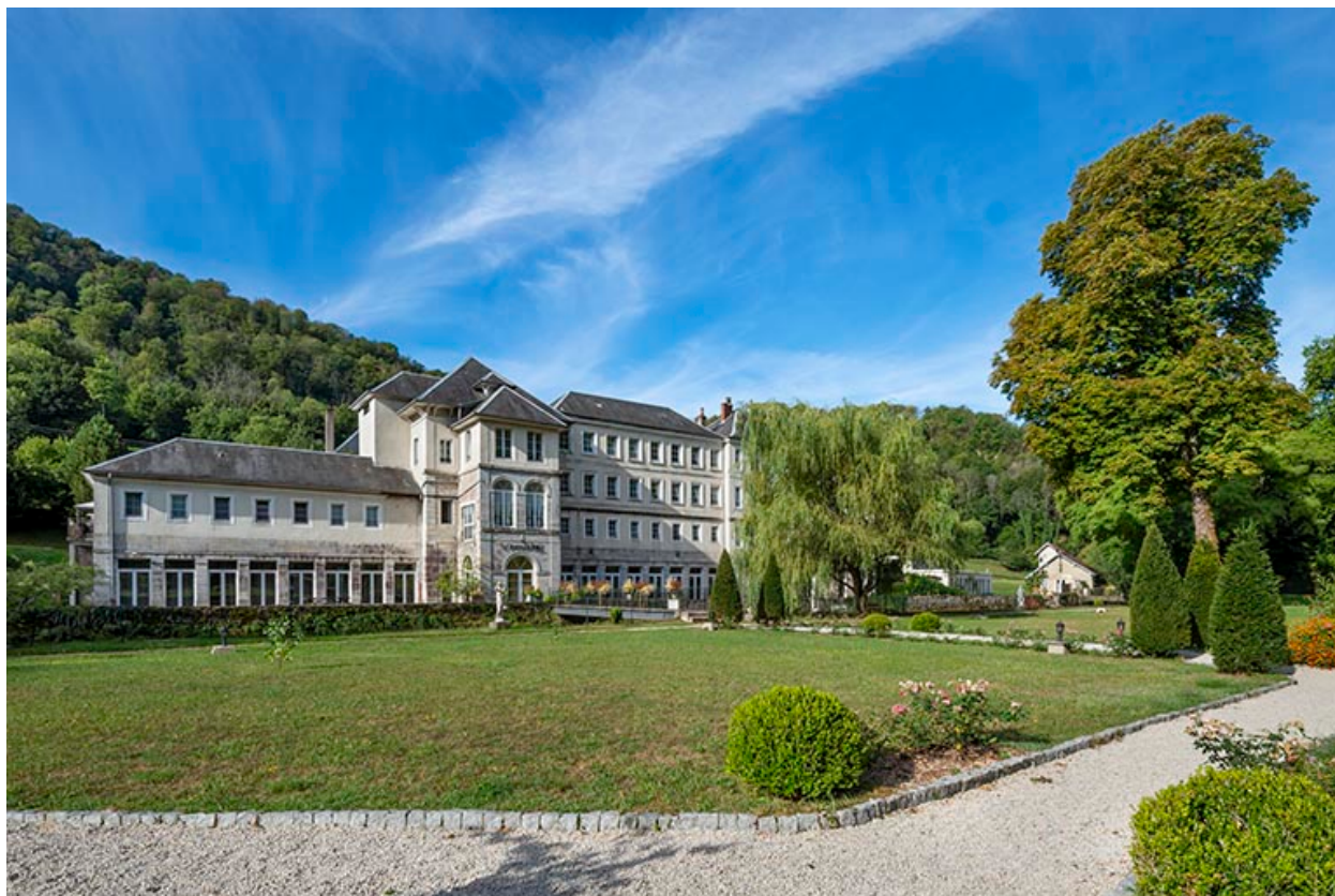
Façade principale, vue de trois quarts.
