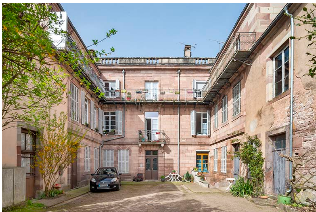
Façade sur la cour.
