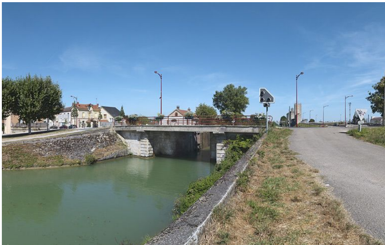
Pont vu d'aval.
