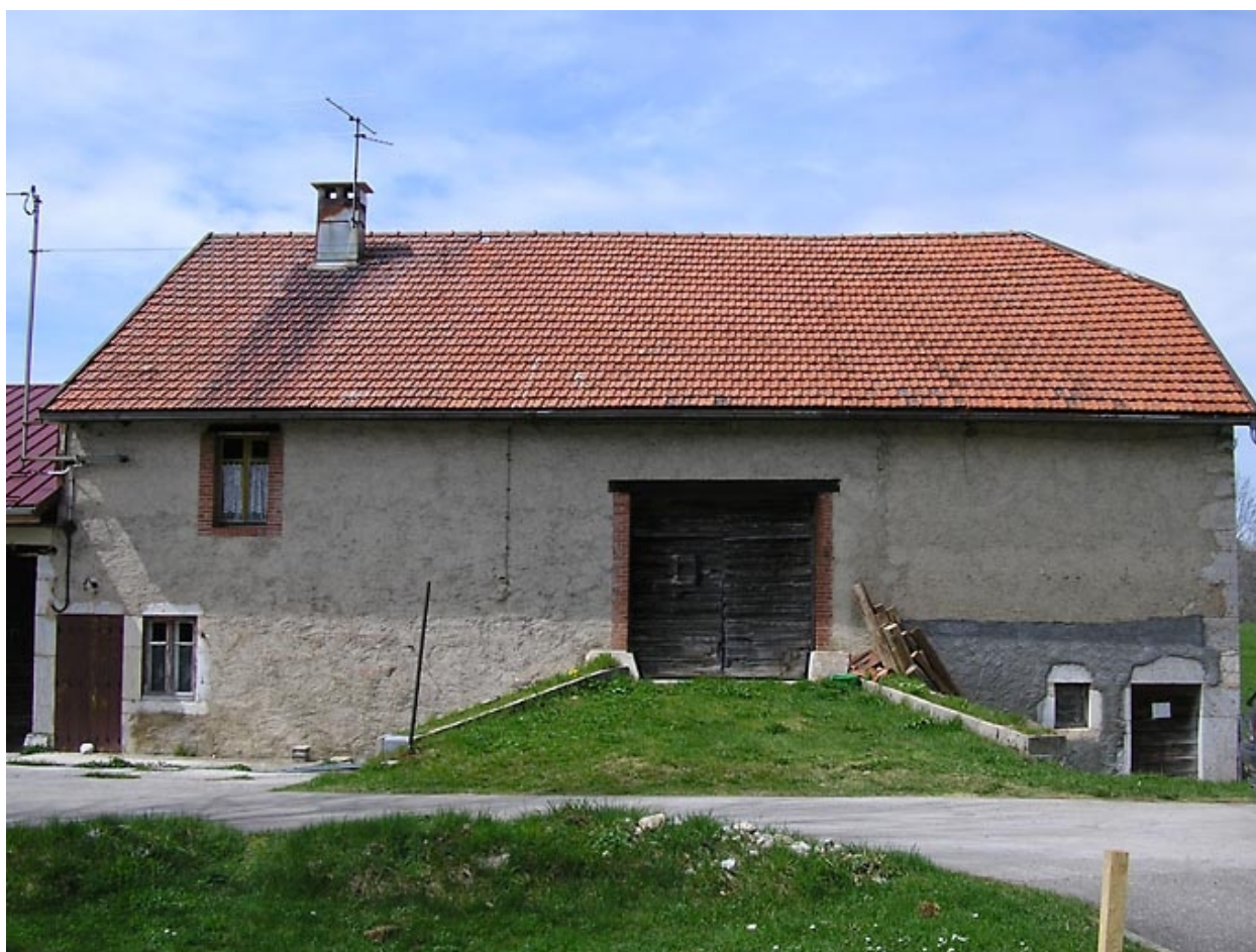
Ferme située au lieu-dit Le Maréchet.
