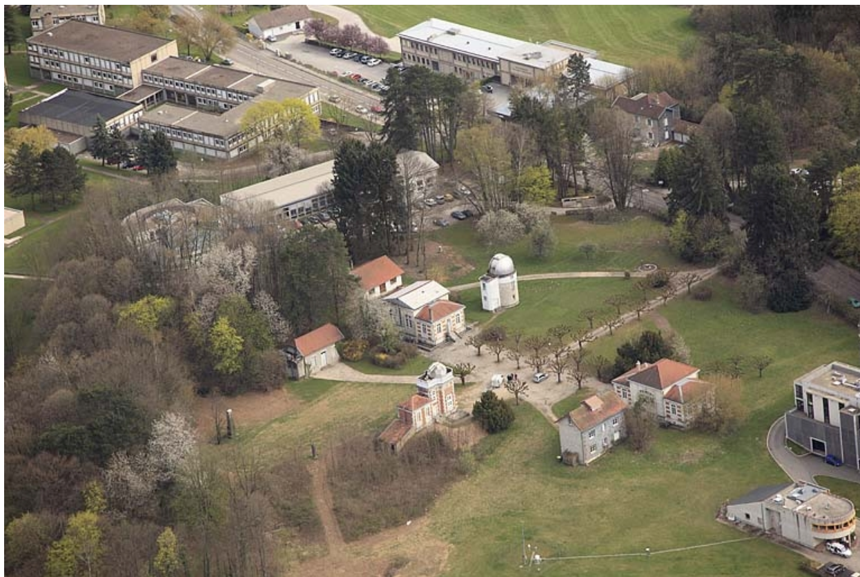
Partie nord : vue aérienne depuis le nord-ouest.
