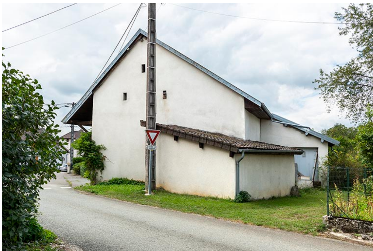
Façade latérale droite.
