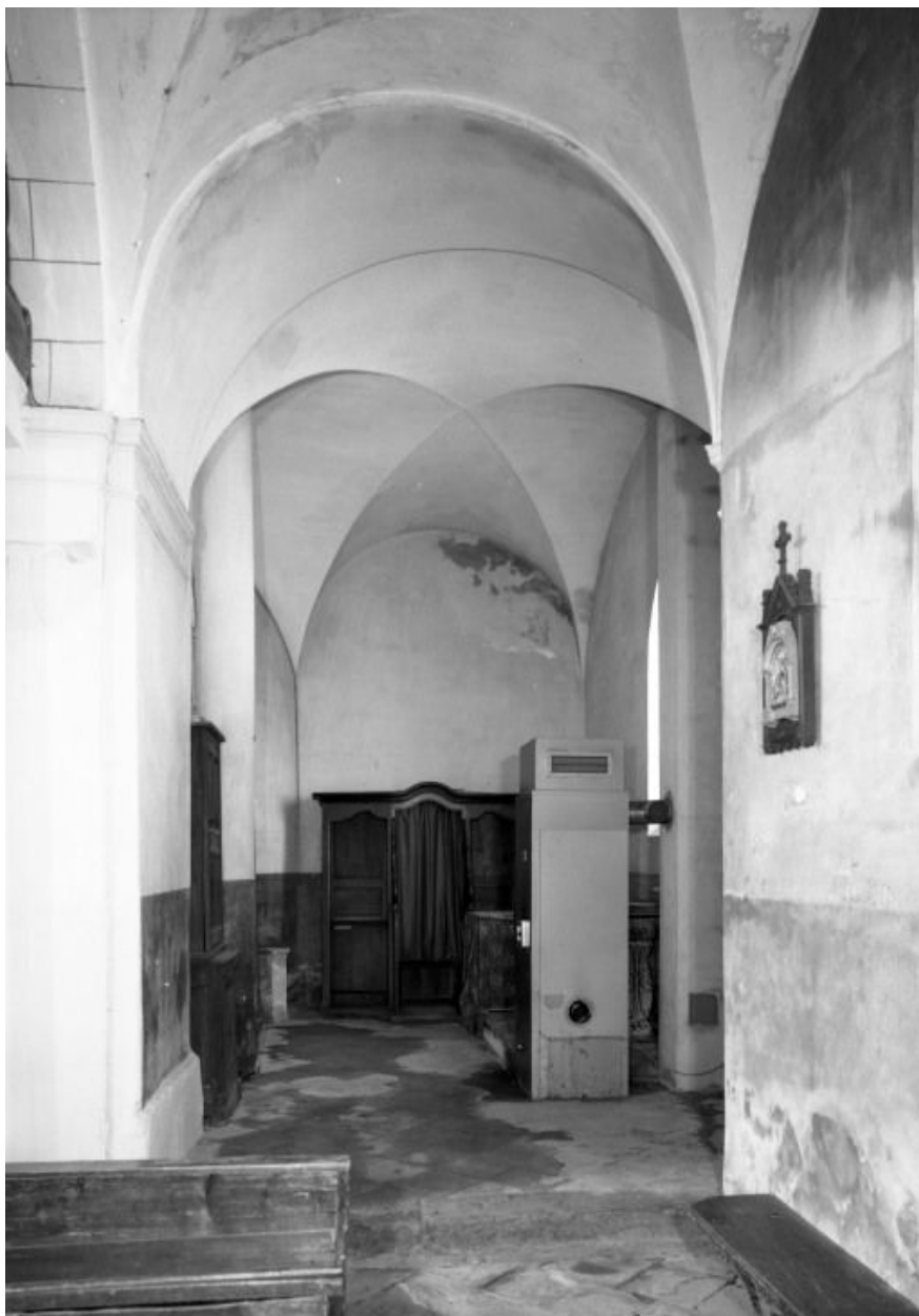
Pièce à droite du vestibule
