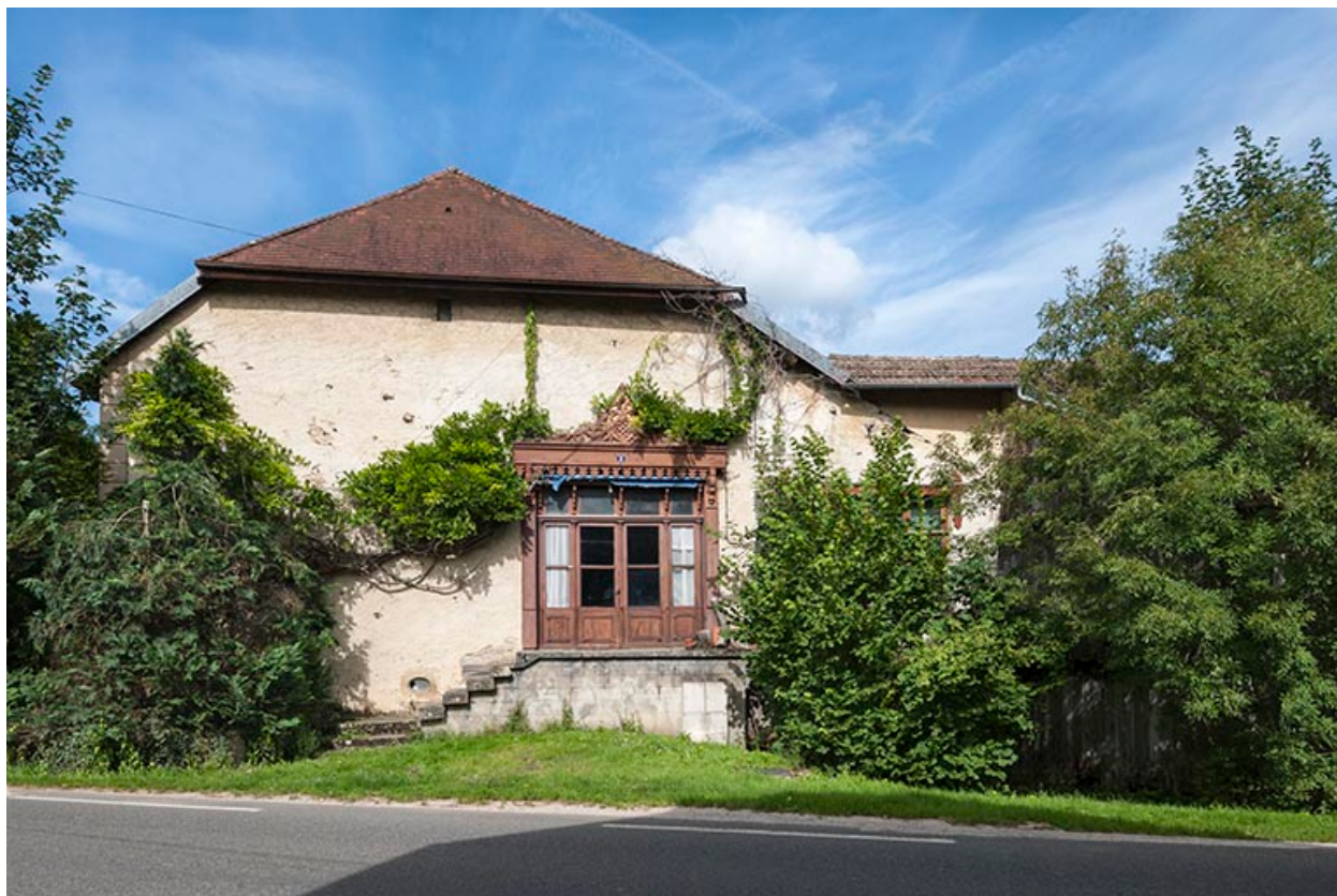
Façade sud de l'atelier.
