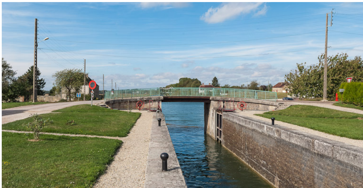
Vue d'ensemble du pont.
