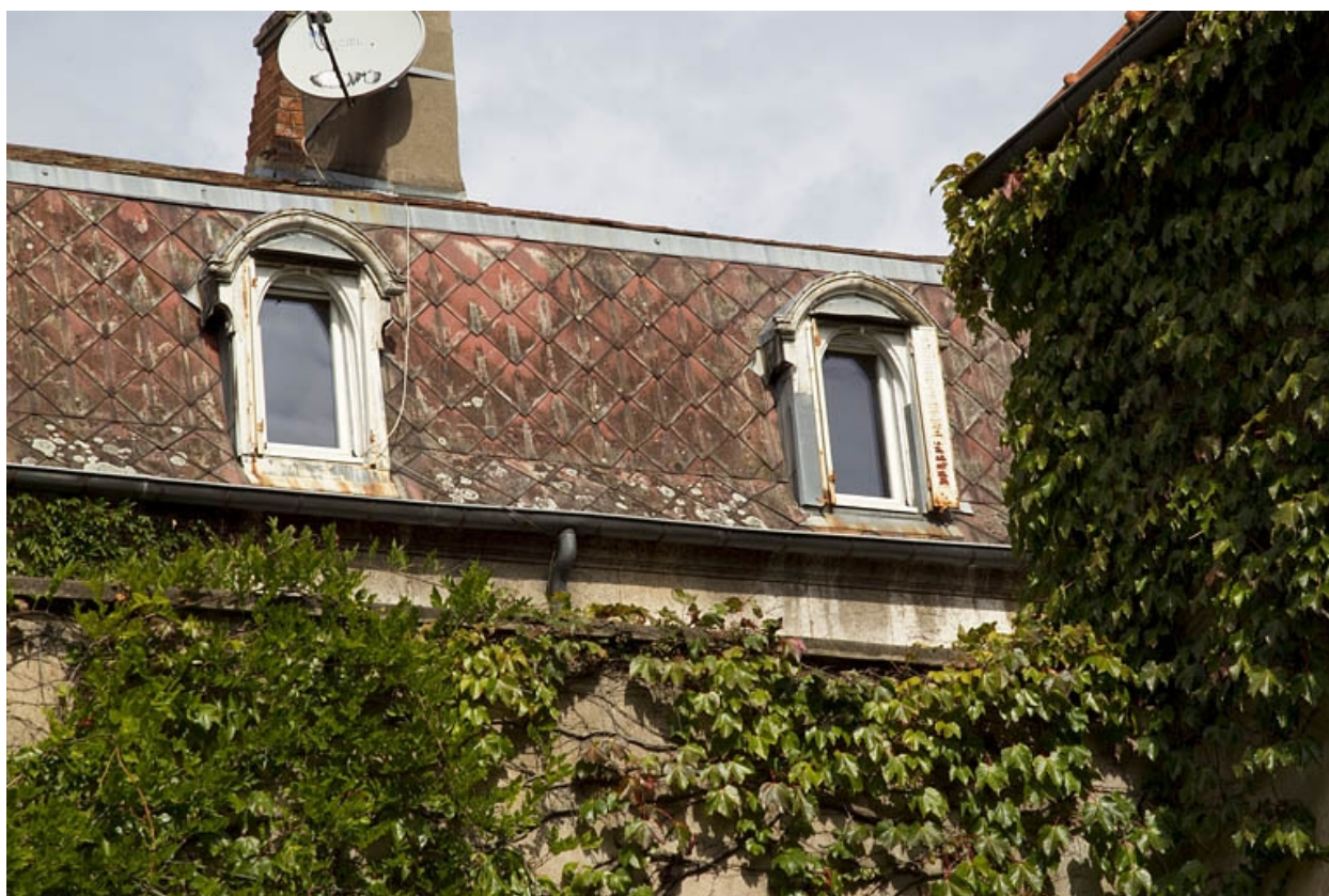
Premier logis secondaire : détail des lucarnes.
