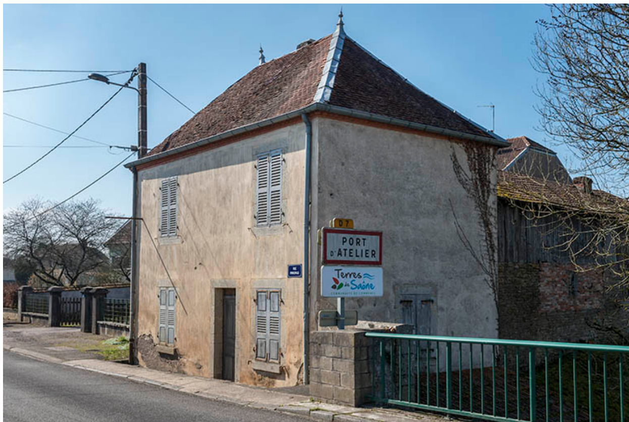
La maison du péagiste à Port-d'Atelier.
