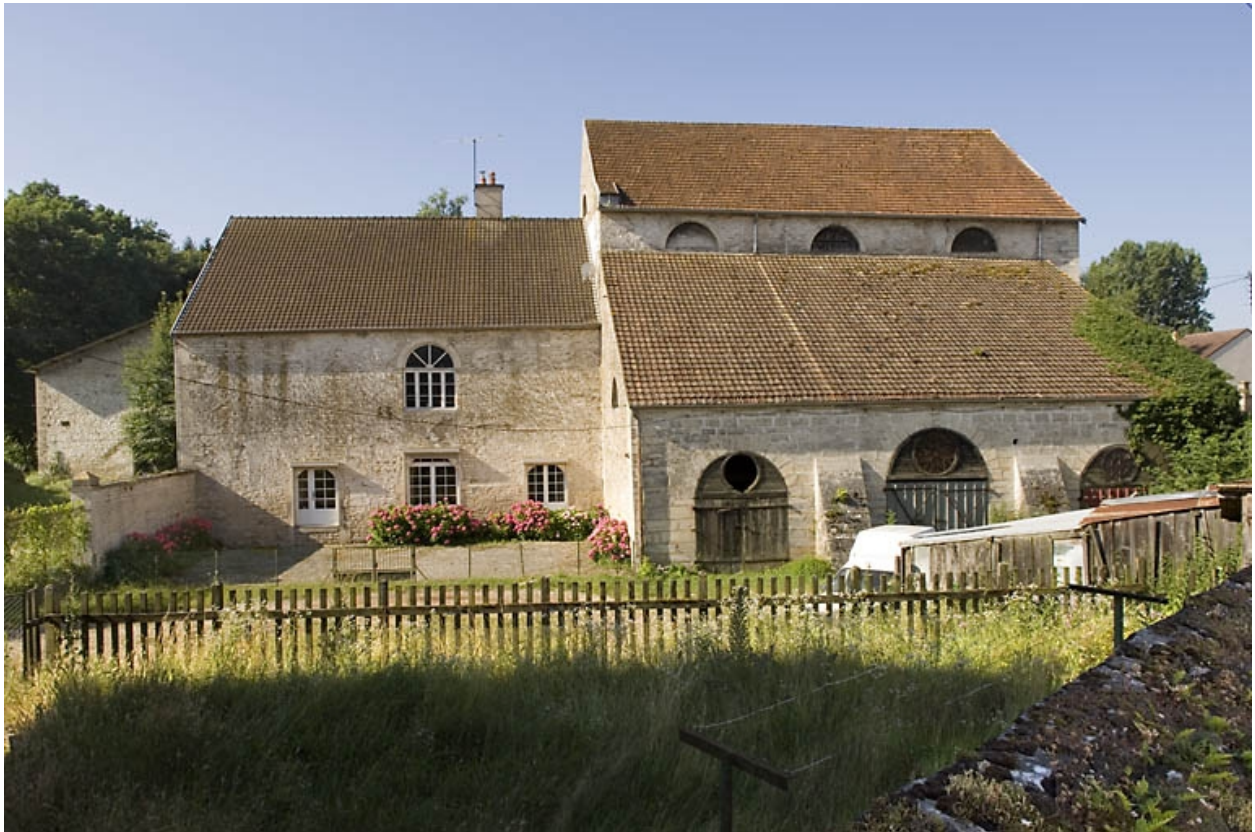
Façade nord du haut fourneau.
