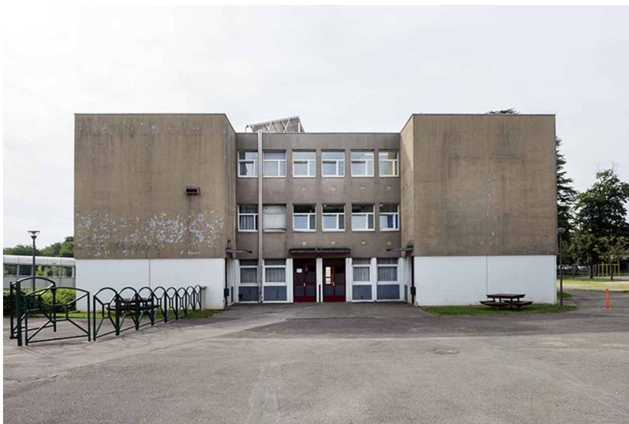
Entrée du bâtiment d'internat et restauration.
