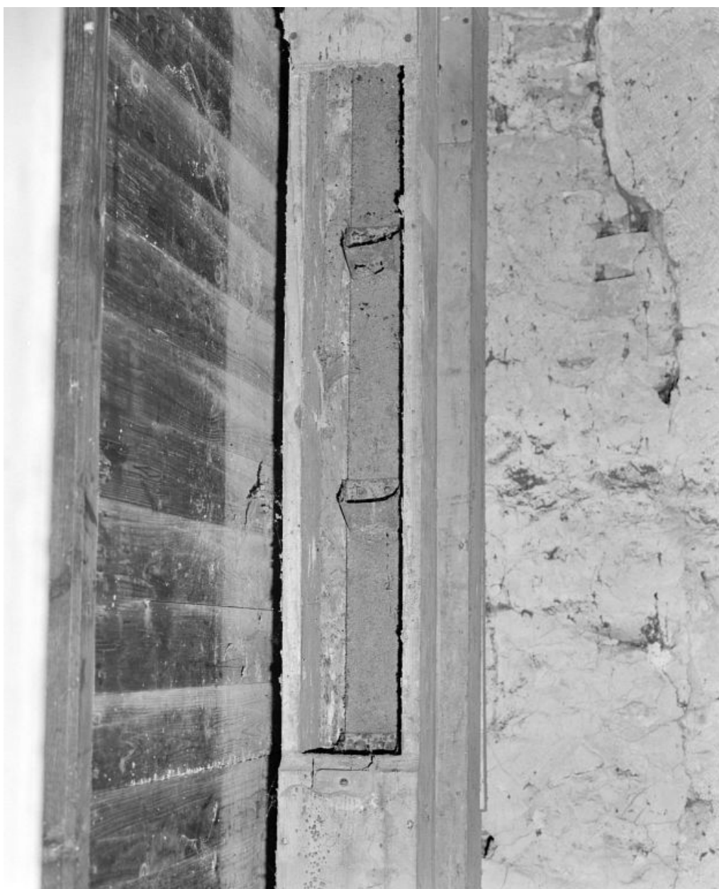
1er étage. Elévateur à godets, détail.
