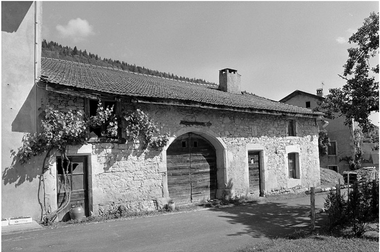
Ferme à trois travées : étable, grange, logis.
