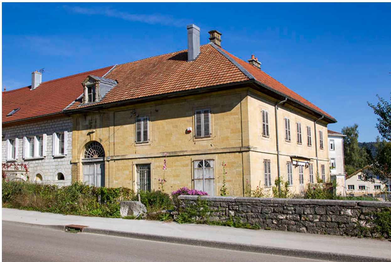
Corps sud : vue d'ensemble, depuis le sud-ouest.
