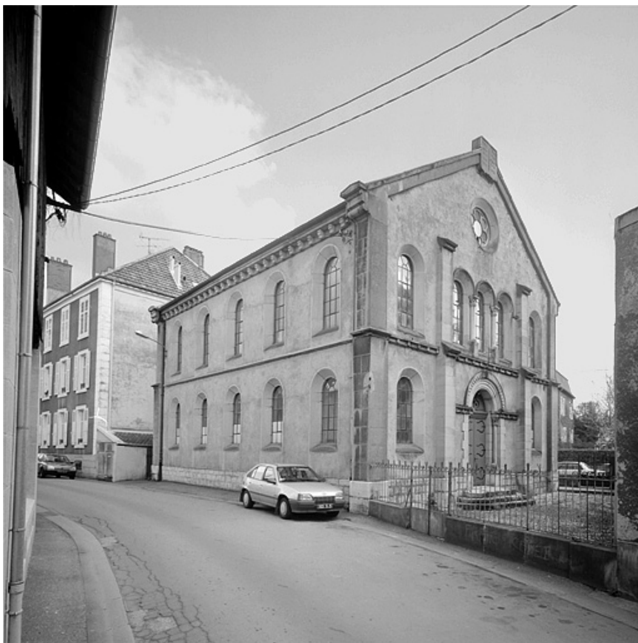
Vue d'ensemble côté rue de la Synagogue.
