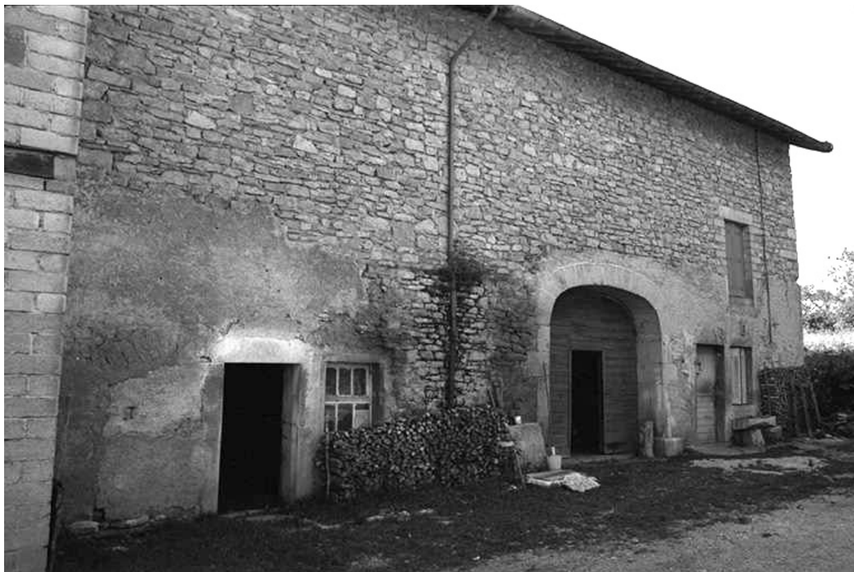
Ferme cadastrée 1957 A1 232 : façade antérieure.
