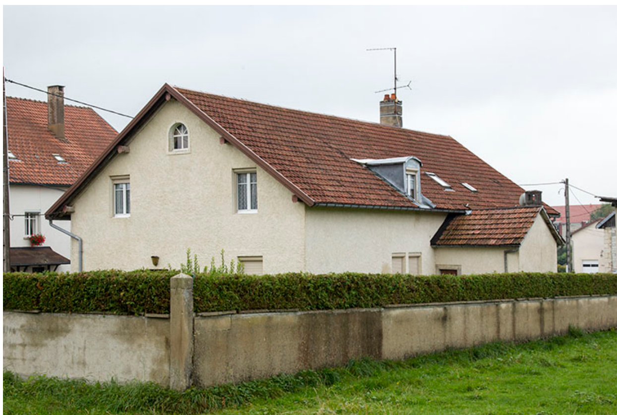
Façades postérieure et latérale droite.
