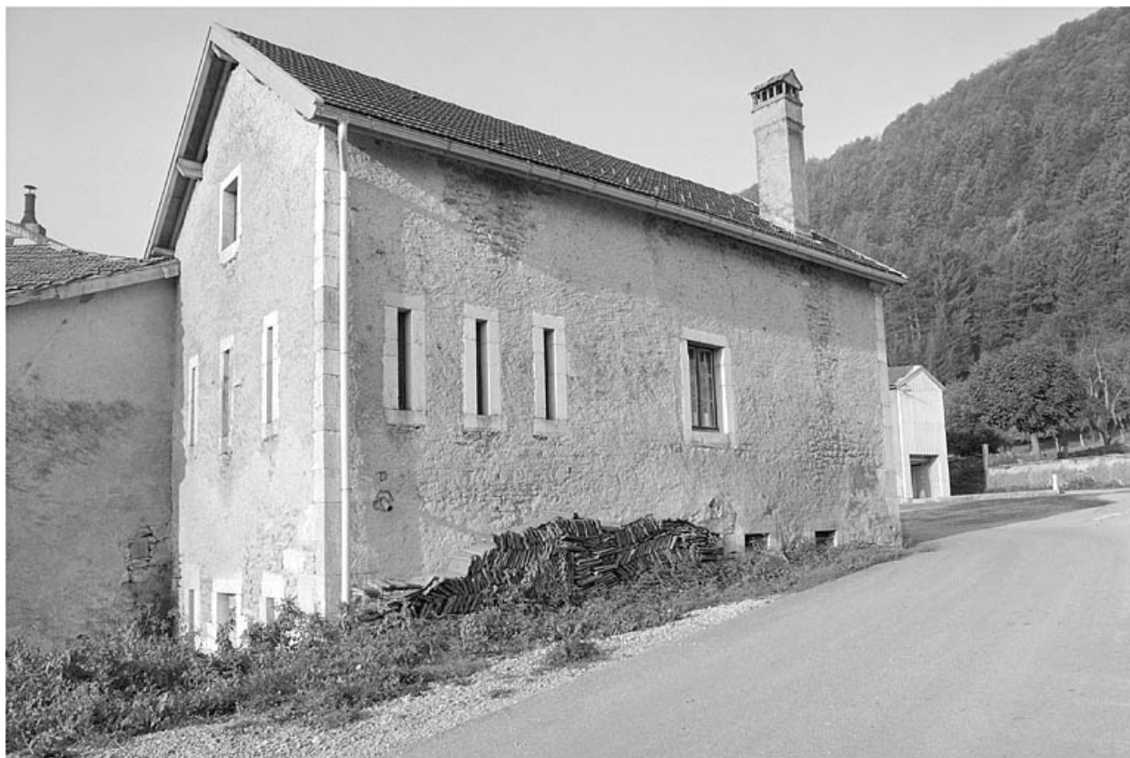
Face gauche et façade postérieure.
