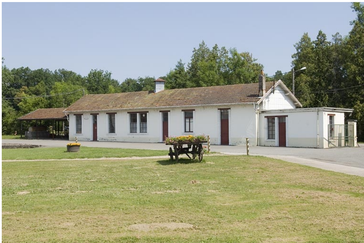
Entrepôt industriel vu de trois quarts.
