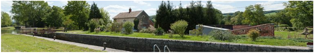
Vue d'ensemble du site d'écluse.
