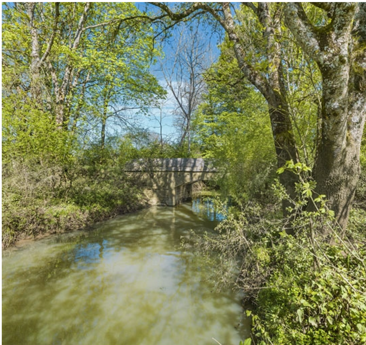
Vue d'ensemble du pont.
