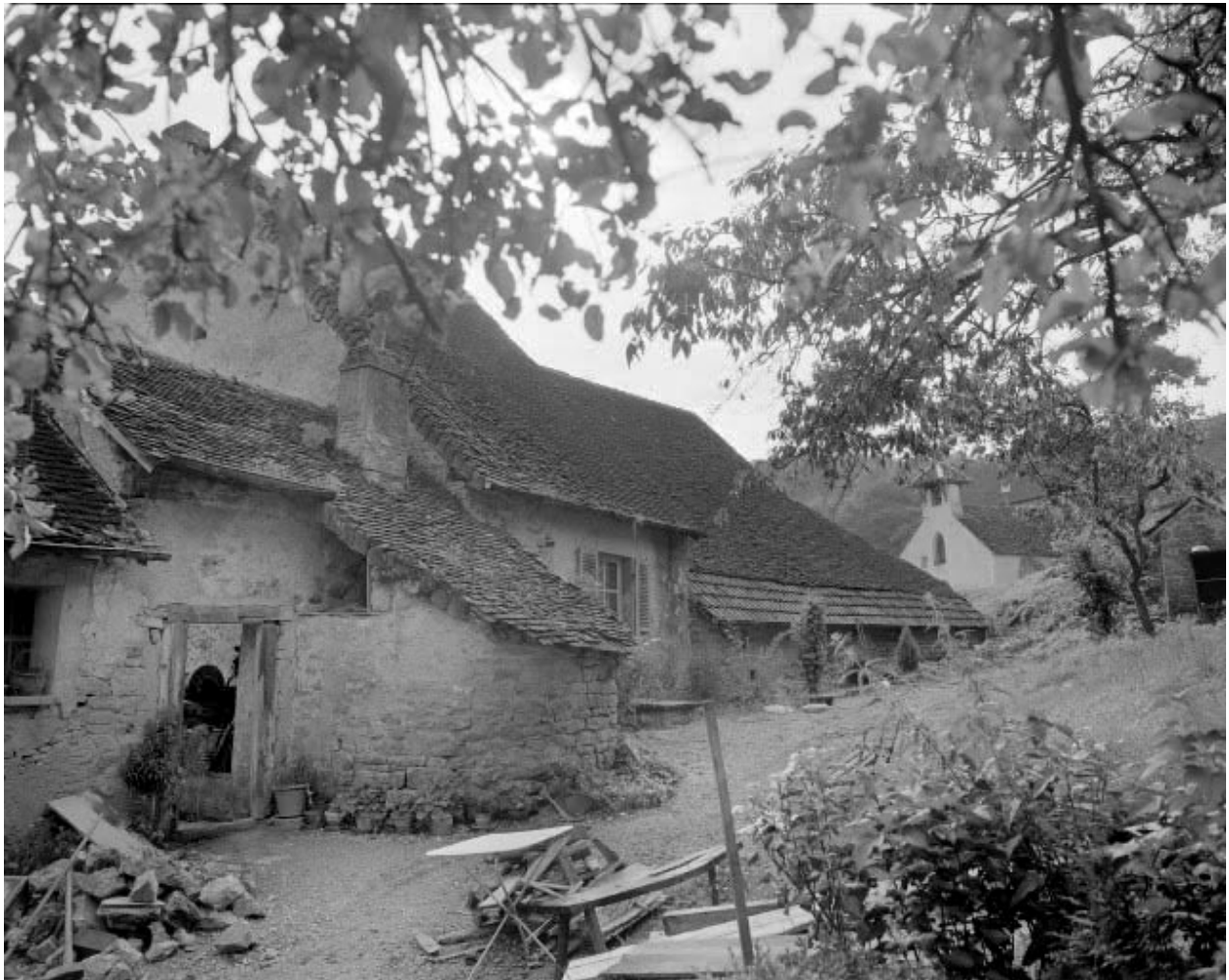
Partie droite de la façade postérieure.
