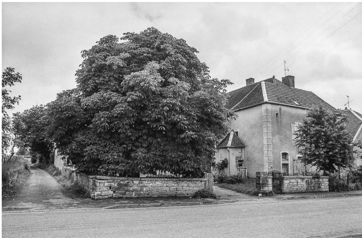
Ferme 1 : vue depuis la rue.
