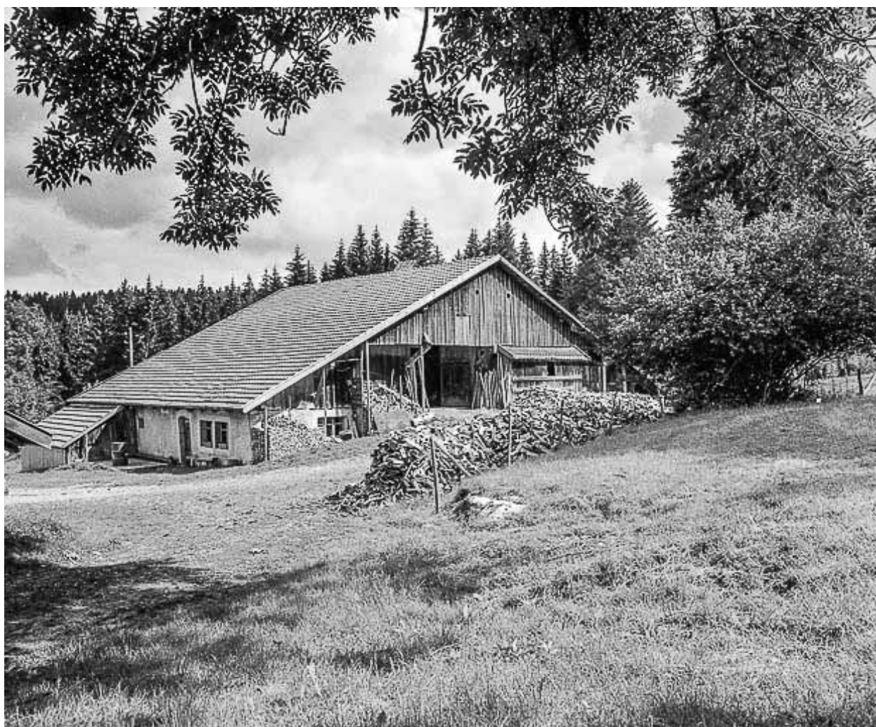
Ferme 1 : façade postérieure.
