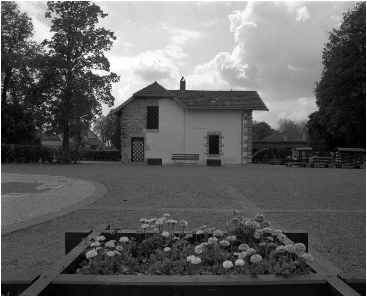
Fabrique de jardin : façade latérale droite.
