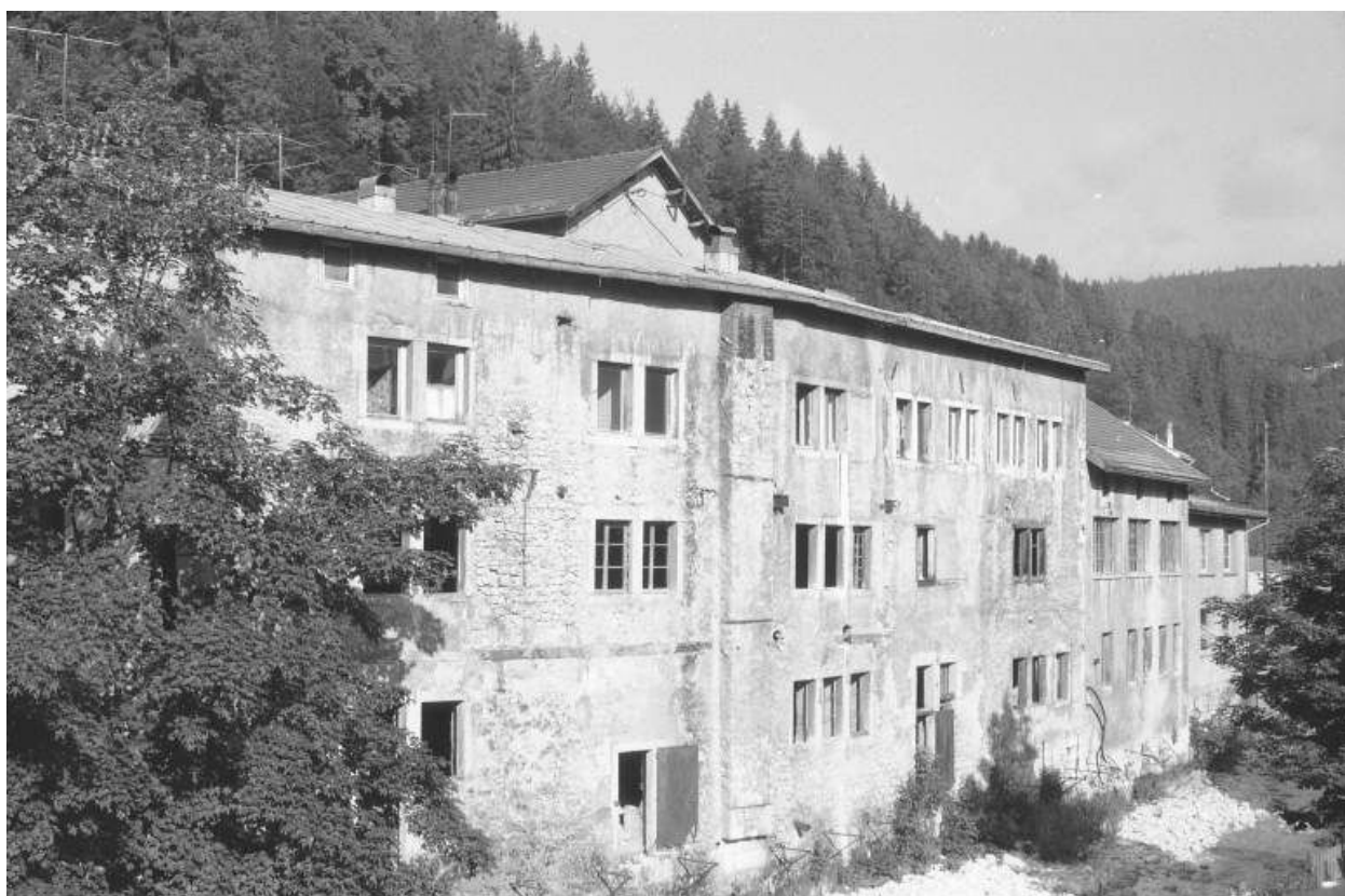
Façade sur la Bienne depuis l'est (amont).
