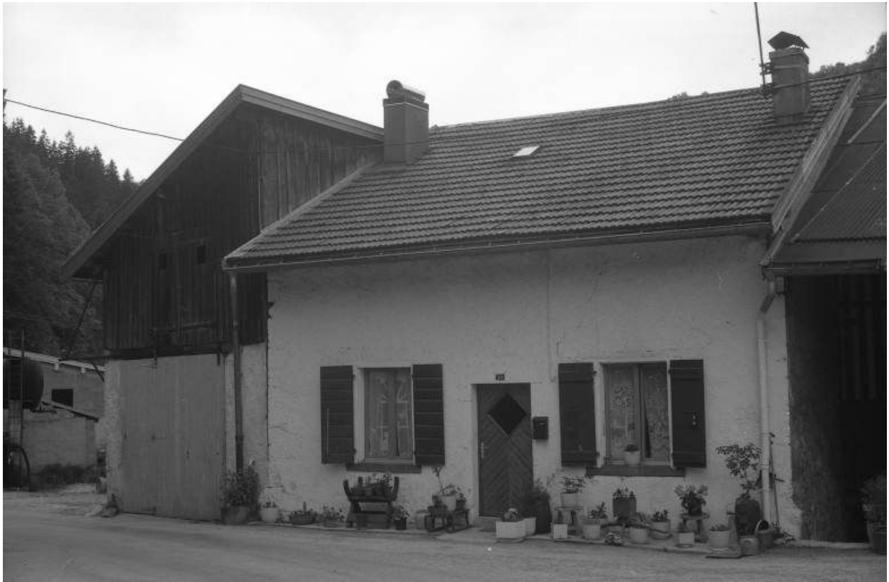
Ancien logement d'ouvriers.
