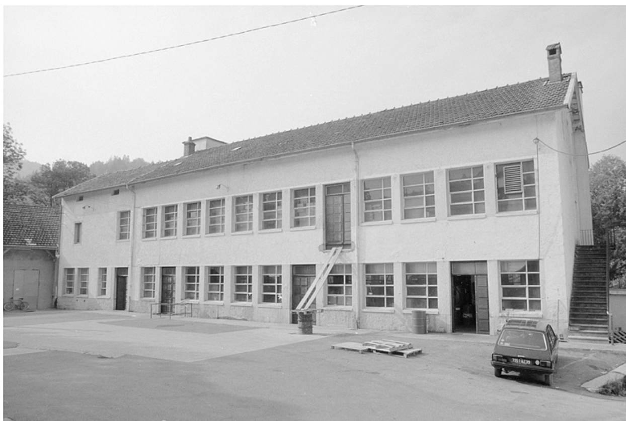
Atelier de fabrication, depuis la cour.
