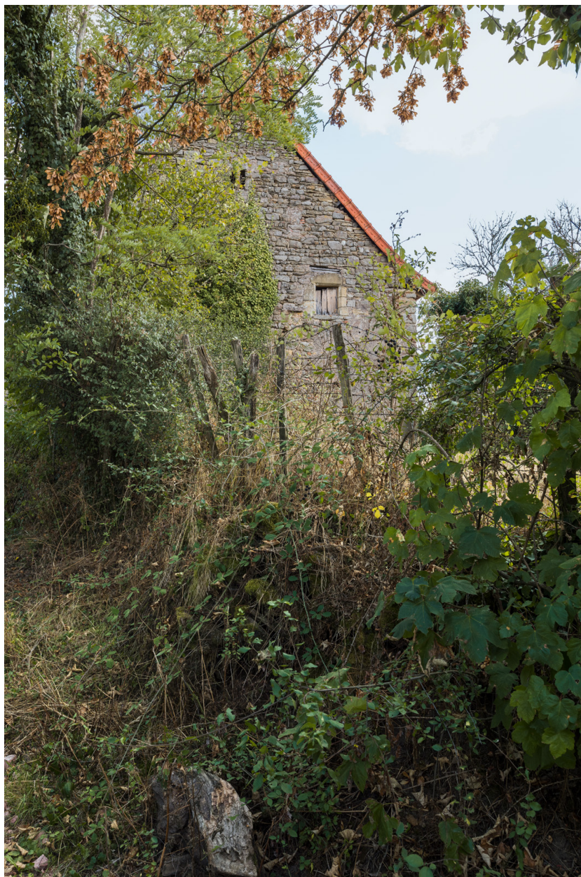
Pignon ouest de la partie agricole.
