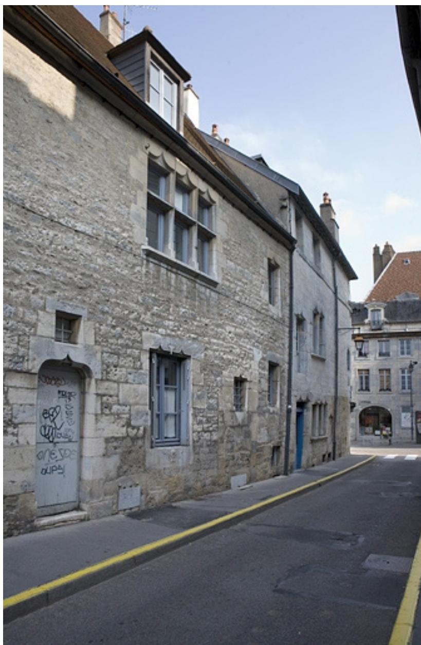
Façade latérale gauche : vue partielle.
