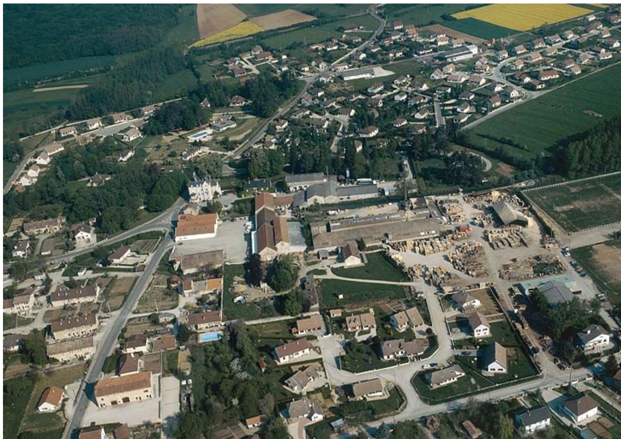
Vue aérienne de l'usine depuis le sud-est.
