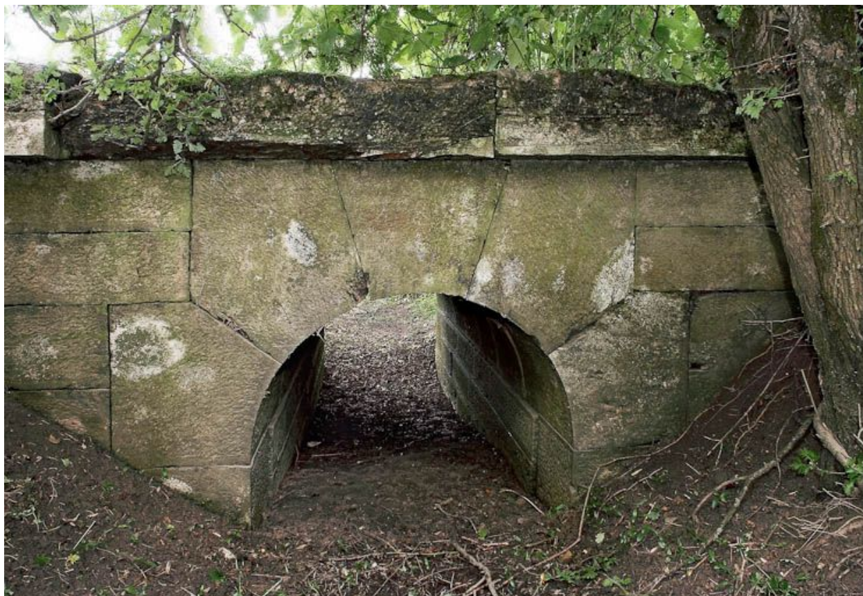
Ponceau, vue rapprochée.
